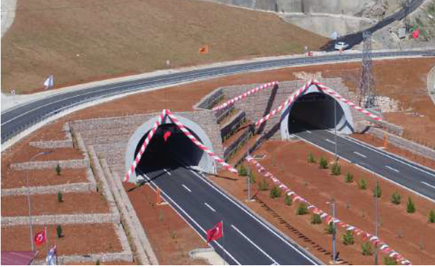
Erkenek Tüneli Bakım Onarım ADİYAMAN - GÖLBAŞI 2024
