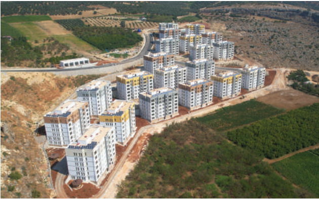
Altınözü 364 Konut Alt Yapı İşİ HATAY 2024
