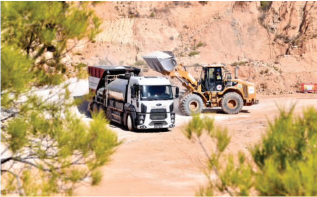
Cadde, Bulvar, Sokaklar ve Kırsal Yollarda Yapım İşi MERSİN 2020
