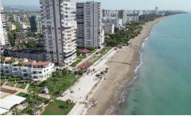
Mezitli İlçesi Sahil Şeridi Yapım İşi MERSİN 2016
