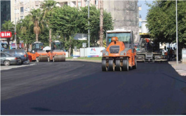
İlçe Yolları Onarımı MERSİN 2024
