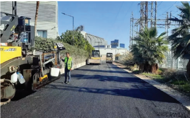
Akdeniz İlçesi Sıcak Asfalt Kaplama İşi MERSİN 2022
