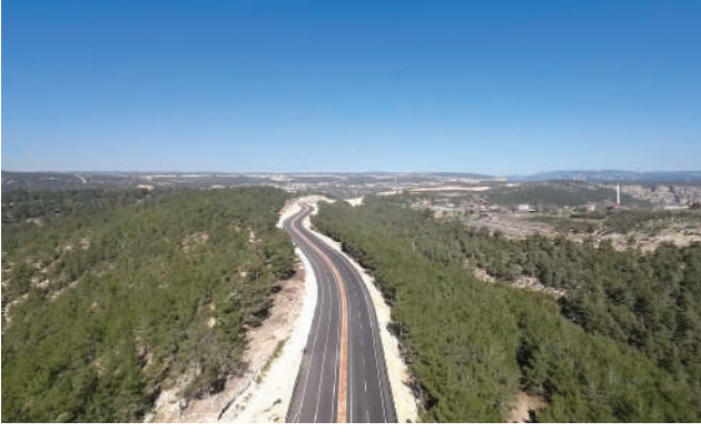
Erdemli - Güzeloluk İl Yolu Çalışmaları MERSİN 2023
